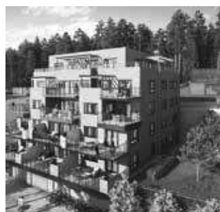
Nowa wspólnota mieszkaniowa Bergås Terasse w Drammen, Norwegia. ECOi / Aquarea
